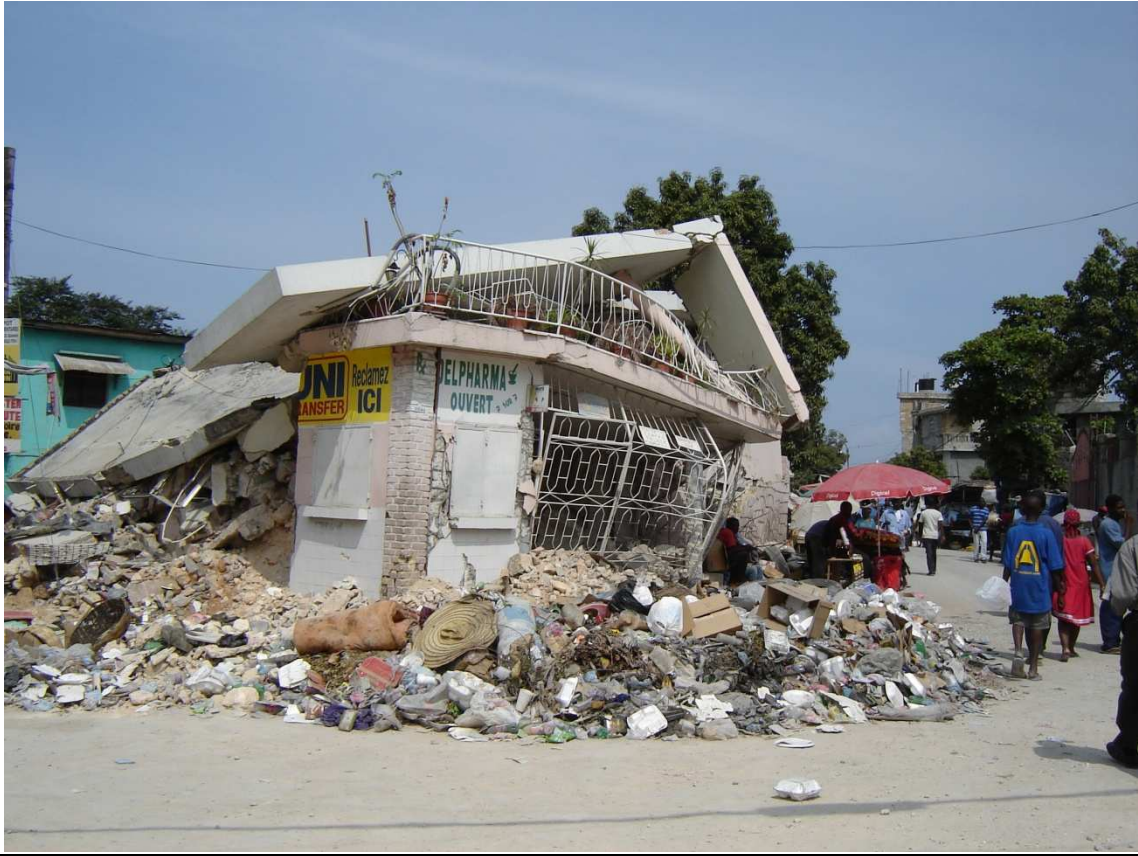
Ejemplo de los efectos destructivos del terremoto en la zona de Tabarre.
