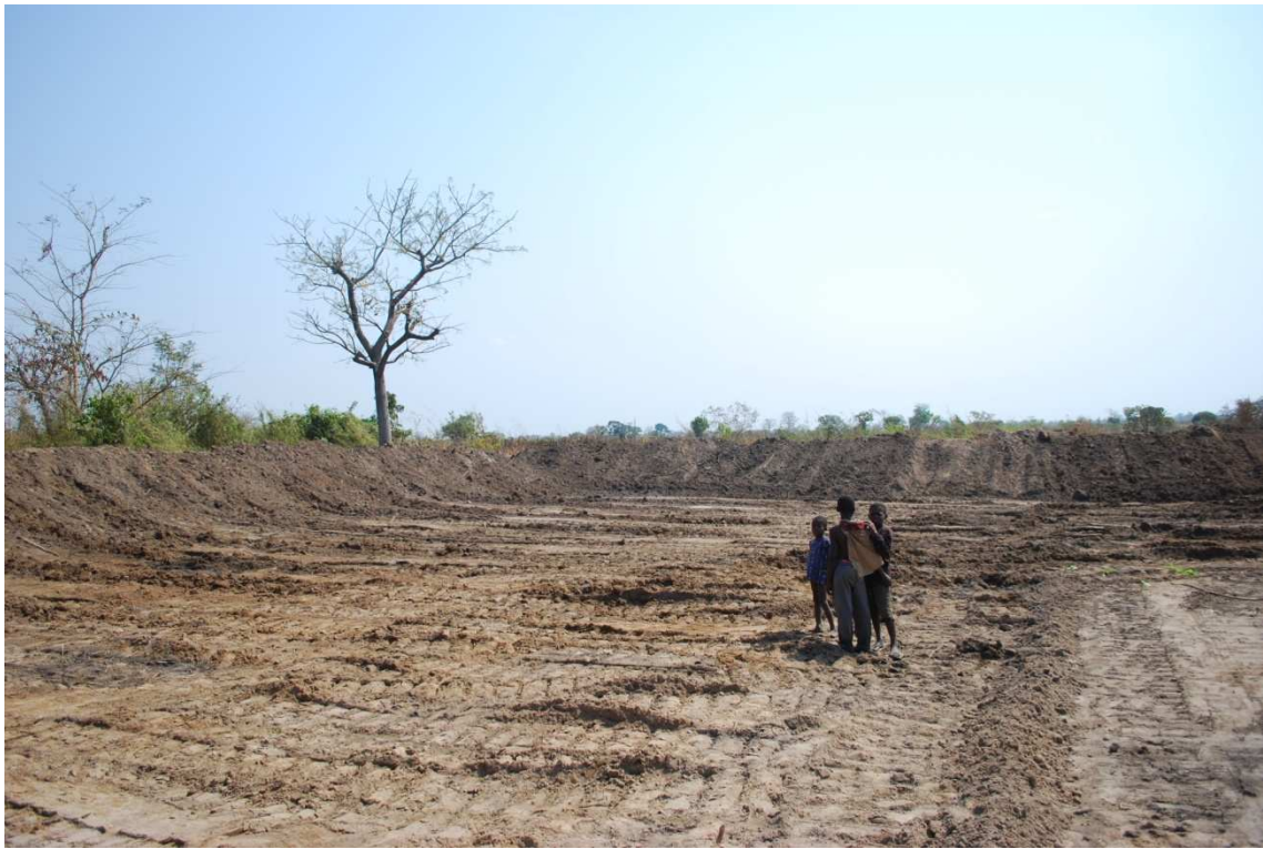
Excavación en el vaso de la presa de retención de agua de lluvias
