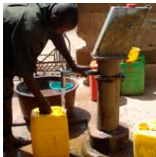
Un habitante del poblado maliense de Djelibani recogiendo agua de los grifos instalados con ayuda de Geólogos sin Fronteras y Casa de Mali.
